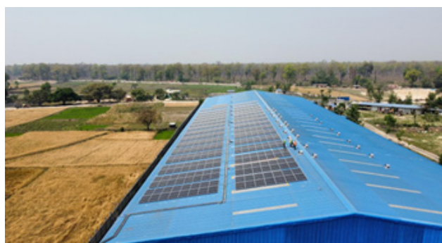
यति कार्पेट इन्डस्ट्रिज वीरगन्जमा जडान गरिएको ३१६.६ किलोवाट पिक क्षमताको सौर्य रूफटप प्रणाली
