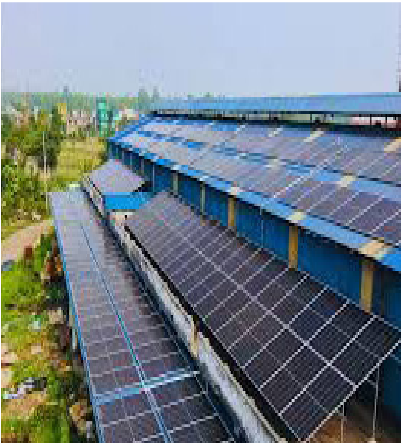
बाराको सिमरास्थित हामा आइरन एण्ड स्टील इन्डस्ट्रीजमा जडित ६३३.६ किलोवाटको रूफटप सोलार
