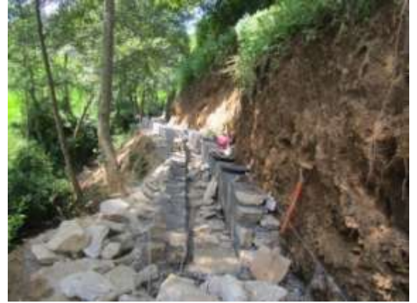
चित्र नं. ४.१६ : कुलोको गारो निर्माण
