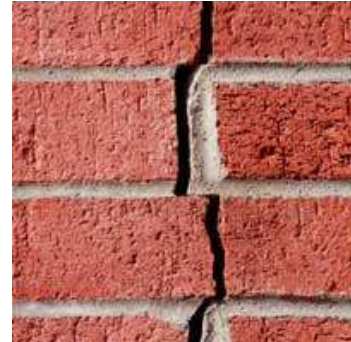
चित्र नं. २.१७ : गलत तरिकाको बाण्डिङ्गका कारण चर्किएको गारो
