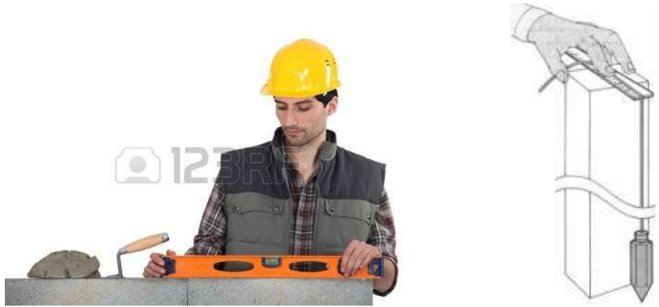
चित्र नं. २.१८ : स्परिट लेभल तथा प्लम्ब बब द्वारा जाँच गर्ने तरिका
