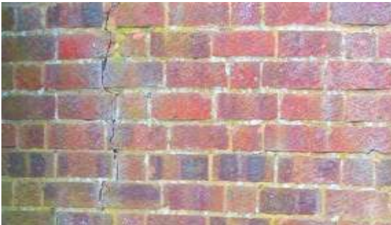
चित्र नं. २.१७ : गलत तरिकाको बाण्डिङ्गका कारण चर्किएको गारो
