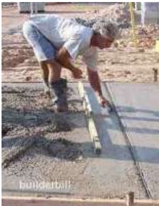
चित्र नं. २.१५ : कंक्रीटको सतह मिलाउने तरिका
