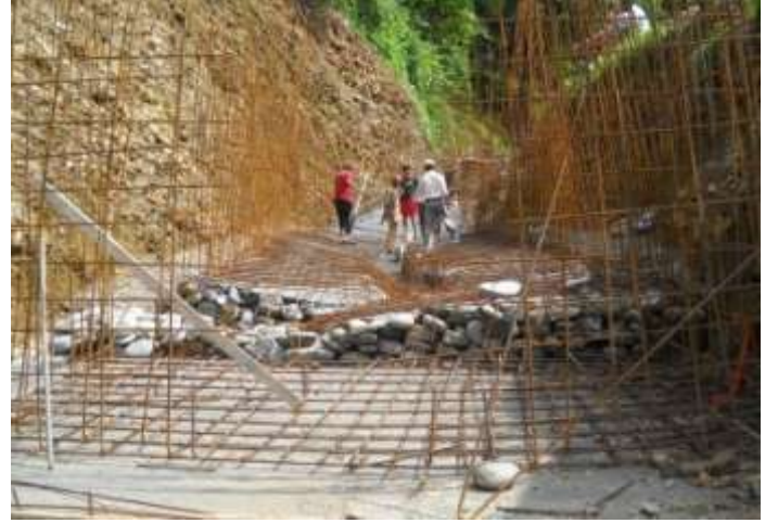
चित्र नं. ४.१० : RCC ढलानको लागि रड बाँध्दै
